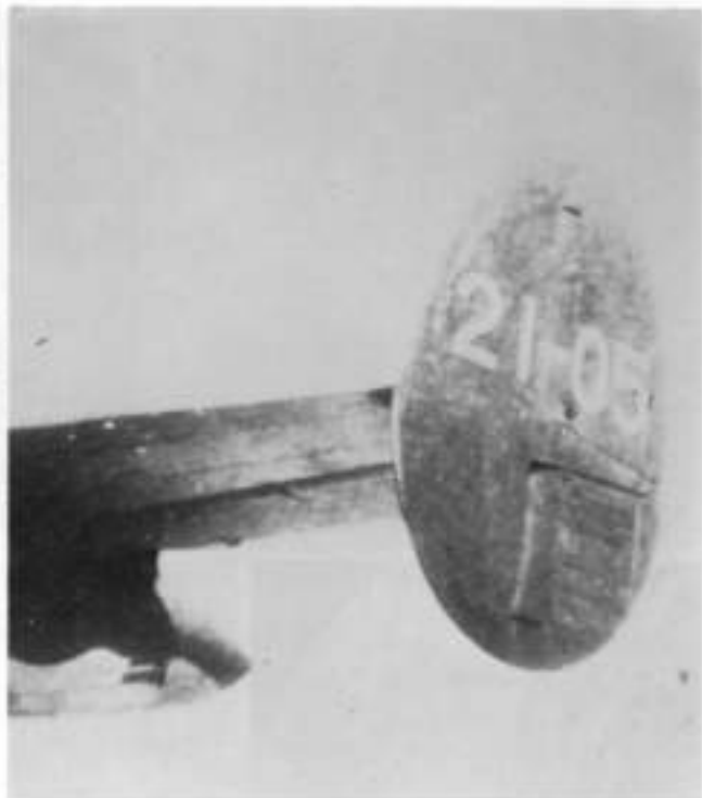
▲ 第1021海軍航空隊で使用中的「深山改」輸送機第4号機の左側垂直尾翼。4は死に逃すというので欠番とし5号機(21-05)としていた。胴体上面を暗緑色、下面は無塗装で、尾翼の文字は黄色に黒でカゲがつけてあった。陸攻型の尾部装置は取りはずされ、写真のように外板で覆ってある。(P.34参照)
